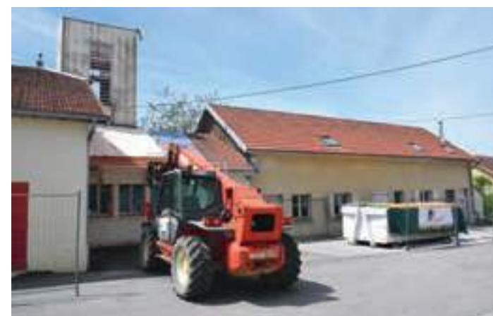
Démontage de la tour pompiers
