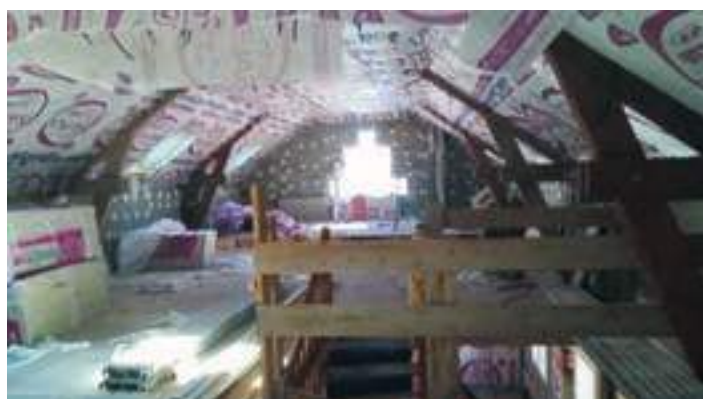
Aperçu des travaux dans les deux logements en phase isolation
