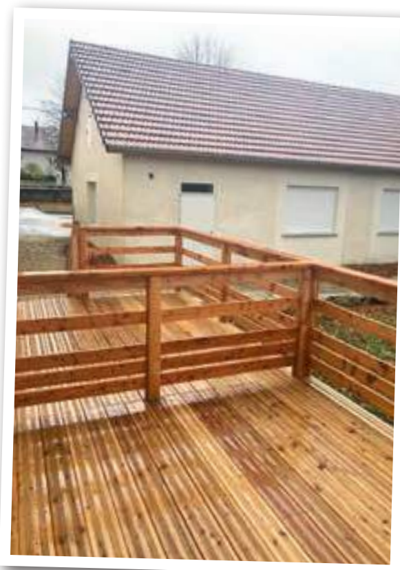
Quelques vues des logements rénovés
