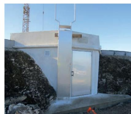
Chambre des vannes avec réfection de la porte d'accès et la mise en place d'une passerelle en inox
