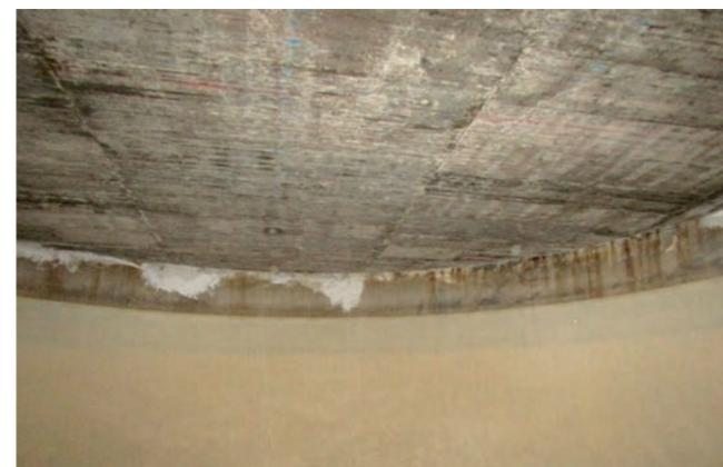
Construction de dalles plates en remplacement des coupôles et nettoyage des radiers
